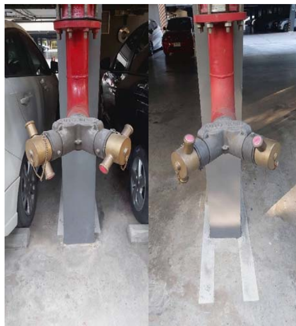
รูปที่ 2.7-2 ห้รรับน้ำดับเพลิงภายในอาคาร
