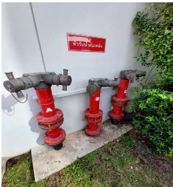
รูปที่ 2.6-1 ห้รรับน้ำดับเพลิงภายนอกอาคาร
