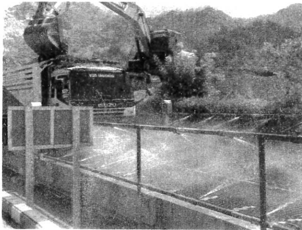
รูปที่ 8 ปรับปรุงระบบล้างล้ออัตโนมัติ และจุดคลุมผ้าใบ
