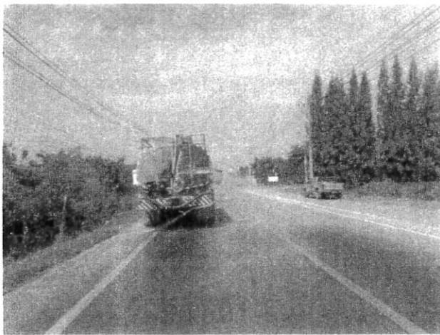
รูปที่ 6 รถบรรทุกน้ำฉีดพรมบนผิวถนนในโรงโม่และถนนชุมชน เพื่อลดฝุ่นละออง
