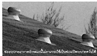
ช่องระบายอากาศลักษณะนี้ไม่ถือว่าเป็นช่องเปิดระบายควัน เนื่องจากไม่สามารถทำงานได้ภายใต้จุดพิกัดสูง
