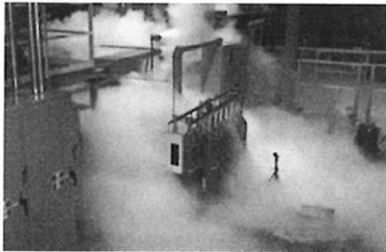
การทำงานของระบบก๊าซคาร์บอนไดออกไซด์ดับเพลิงตามมาตรฐาน NFPA 12
