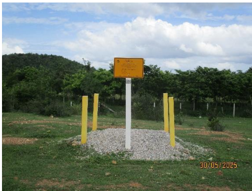
ภาพที่ 2-5 ป้ายและสัญลักษณ์แสดงตำแหน่งแนววางท่อส่งก๊าซ
