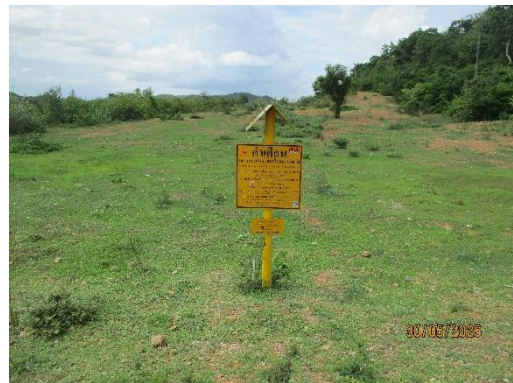
ภาพที่ 2-5 ป้ายและสัญลักษณ์แสดงตำแหน่งแนววางท่อส่งก๊าซ
