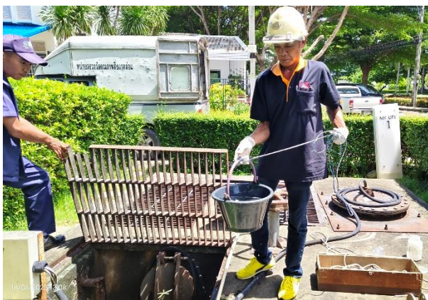
รูปที่ ก-12 ตรวจสอบท่อระบายน้ำรวมภายในโครงการ
