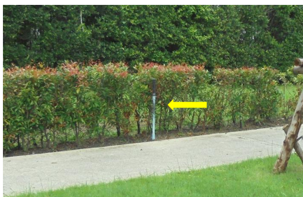
รูปที่ ก-6 น้ำที่ผ่านการบำบัดนำมาใช้รดน้ำต้นไม้บนพื้นที่สีเขียวโดยใช้ระบบสปริงเกอร์
