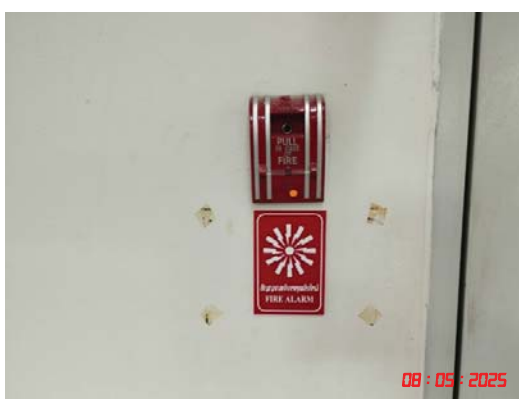
อุปกรณ์แจ้งเหตุเพลิงไหม้แบบดึงมือ
