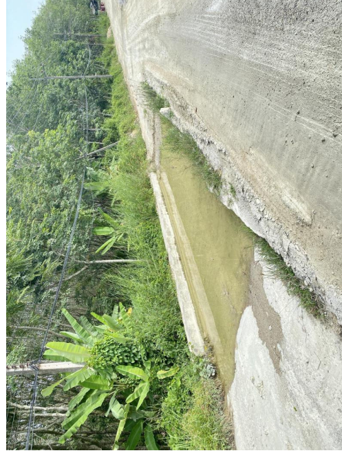
ภาพที่ 12 บ่อล้างล้อรถบรรทุกก่อนขึ้นคันขัง
