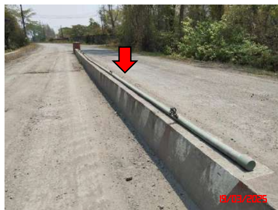
รูปที่ 9 ลานล้างล้อรถบรรทุกขนส่งแร่
