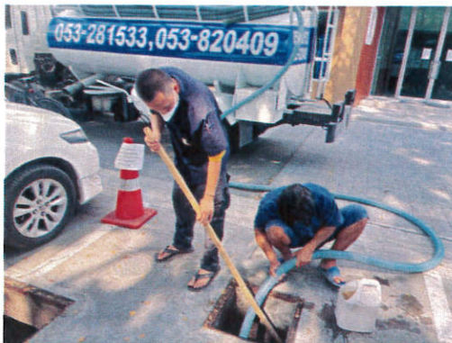
ภาพที่ 2-9 สุ่มตะกอนและตกไขมัน
