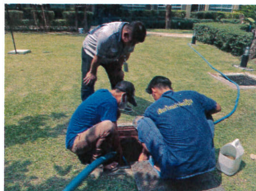
ภาพที่ 2-9 สุ่มตะกอนและตกไขมัน
