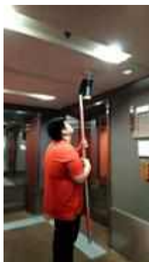
FL 25 หน้าลิฟท์ถูกค้ำ TEST SMOKE DETECTOR 1 SET..NORMAL
