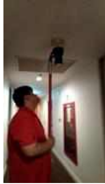
FL 28 ทางเดิน TEST SMOKE DETECTOR 4 SET..NORMAL
