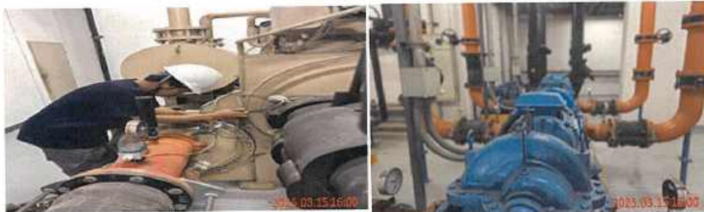
ภาพประกอบที่ 5 การซ่อมบำรุงเครื่องทำน้ำเย็น
