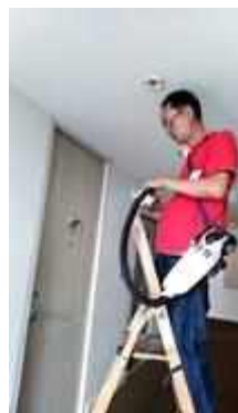
FL 20 ทางเดิน TEST SMOKE DETECTOR 5 SET..NORMAL
