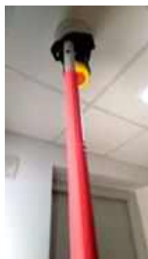
FL 20 หน้าลิฟท์พนักงาน TEST SMOKE DETECTOR 1 SET..NORMAL
