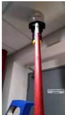
FL 19 หน้าลิฟท์พนักงาน TEST SMOKE DETECTOR 1 SET..NORMAL
