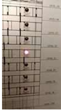
FL 21 ทางเดิน TEST SMOKE DETECTOR 5 SET..NORMAL
