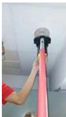
FL 22 หน้าลิฟท์พนักงาน TEST SMOKE DETECTOR 1 SET..NORMAL
