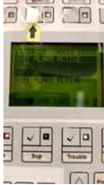
FL 18 หน้าลิฟท์ลูกค้ำ TEST SMOKE DETECTOR 1 SET..NORMAL
