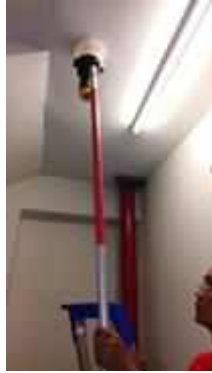
FL 18 บันไดหนีไฟ TEST SMOKE DETECTOR 1 SET..NORMAL
