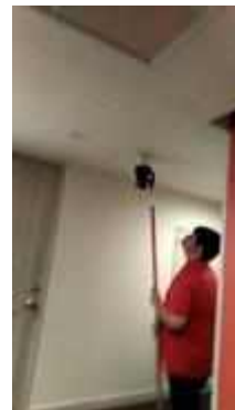
FL 27 หน้าลิฟท์พนักงาน TEST SMOKE DETECTOR 1 SET..NORMAL
