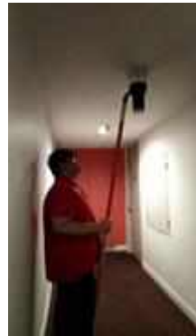
FL 28 หน้าลิฟท์ลูกค้ำ TEST SMOKE DETECTOR 1 SET..NORMAL
