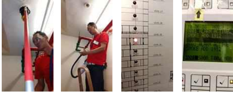
FL 24 หน้าบันไดหนีไฟ TEST SMOKE DETECTOR 1 SET..NORMAL
