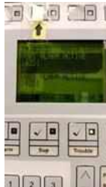
FL 16 ทางเดิน TEST SMOKE DETECTOR 4 SET..NORMAL
