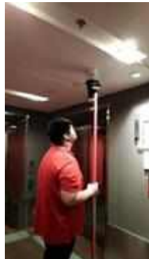
FL 28 หน้าลิฟท์ลูกค้ำ TEST SMOKE DETECTOR 1 SET..NORMAL
