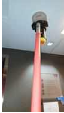
FL 18 หน้าลิฟท์ลูกค้ำ TEST SMOKE DETECTOR 1 SET..NORMAL
