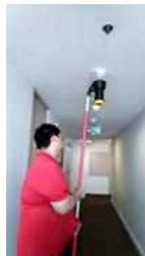
FL 28 หน้าลิฟต์พนักงาน TEST SMOKE DETECTOR 1 SET..NORMAL
