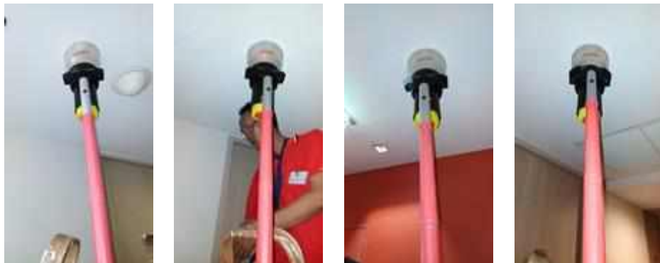
FL 23 หน้าลิฟท์พนักงาน TEST SMOKE DETECTOR 1 SET..NORMAL
