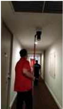
FL 28 หน้าลิฟท์ลูกค้ำ TEST SMOKE DETECTOR 1 SET..NORMAL
