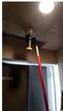
FL 28 หน้าลิฟต์พนักงาน TEST SMOKE DETECTOR 1 SET..NORMAL
