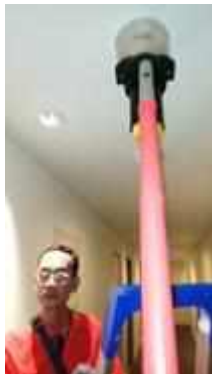
FL 16 หน้าลิฟท์ลูก้า TEST SMOKE DETECTOR 1 SET..NORMAL
