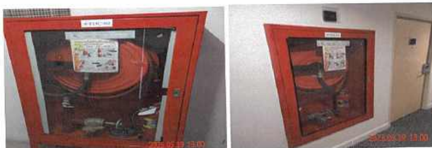
ภาพประกอบที่ 33 สายฉีดดับเพลิง ถังดับเพลิงและตู้สายฉีดดับเพลิง
