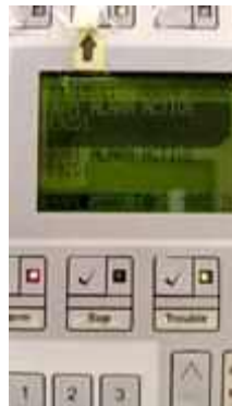
FL 19 หน้าลิฟท์ลูกค้า TEST SMOKE DETECTOR 1 SET..NORMAL
