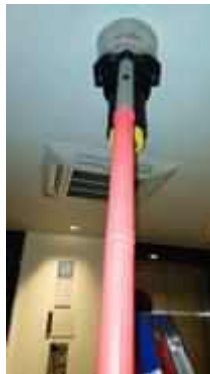
FL 17 หน้าลิฟท์ลูกค้ำ TEST SMOKE DETECTOR 1 SET..NORMAL
