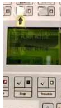
FL 18 หน้าลิฟท์พนักงาน TEST SMOKE DETECTOR 1 SET..NORMAL
