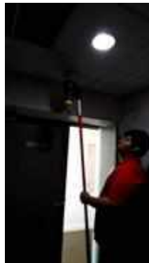
FL 27 หน้าลิฟท์พนักงาน TEST SMOKE DETECTOR 1 SET..NORMAL
