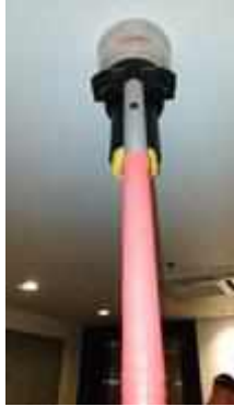
FL 16 หน้าลิฟท์ลูก้า TEST SMOKE DETECTOR 1 SET..NORMAL
