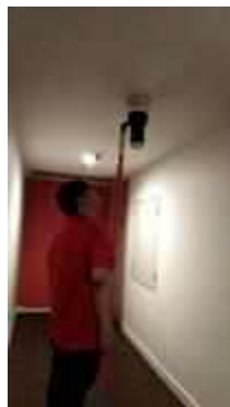
FL 28 หน้าลิฟต์พนักงาน TEST SMOKE DETECTOR 1 SET..NORMAL
