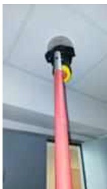
FL 18 หน้าลิฟท์พนักงาน TEST SMOKE DETECTOR 1 SET..NORMAL
