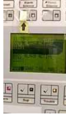
FL 20 หน้า PANTY ROOM TEST SMOKE DETECTOR 1 SET..NORMAL
