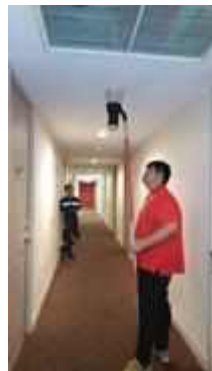
FL 27 หน้าลิฟท์พนักงาน TEST SMOKE DETECTOR 1 SET..NORMAL
