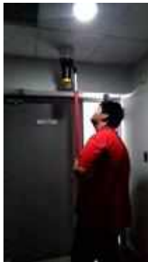
FL 26 หน้าลิฟท์พนักงาน TEST SMOKE DETECTOR 4 SET..NORMAL
