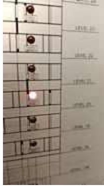
FL 20 หน้า PANTY ROOM TEST SMOKE DETECTOR 1 SET..NORMAL
