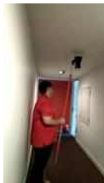
FL 26 ทางเดิน TEST SMOKE DETECTOR 4 SET..NORMAL
