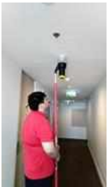
FL 27 ทางเดิน TEST SMOKE DETECTOR 4 SET..NORMAL
