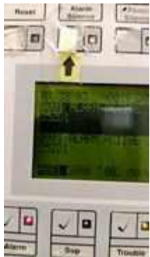
FL 25 หน้าลิฟท์พนักงาน TEST SMOKE DETECTOR 1 SET..NORMAL
