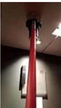
FL 20 หน้าลิฟท์ลูกค้า TEST SMOKE DETECTOR 1 SET..NORMAL
