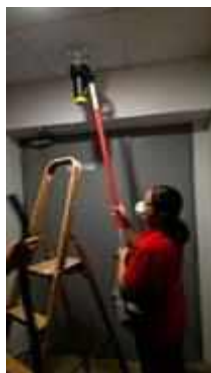
FL 24 หน้าลิฟท์พนักงาน TEST SMOKE DETECTOR 1 SET..NORMAL
