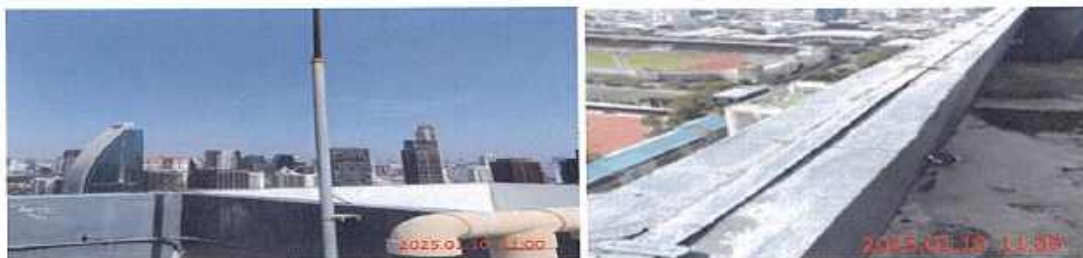
ภาพประกอบที่ 38 ระบบป้องกันอันตรายจากฟ้าผ่า
