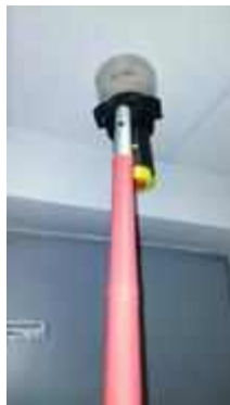
FL 17 หน้าลิฟท์พนักงาน TEST SMOKE DETECTOR 1 SET..NORMAL
