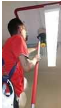
FL 23 หน้า PANTY ROOM TEST SMOKE DETECTOR 1 SET..NORMAL
