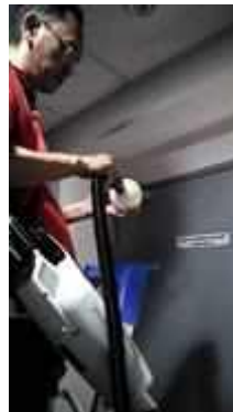
FL 19 หน้าลิฟท์พนักงาน TEST SMOKE DETECTOR 1 SET..NORMAL
