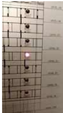
FL 21 หน้า PANTY ROOM TEST SMOKE DETECTOR 1 SET..NORMAL
