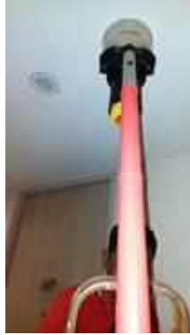
FL 23 ทางเดิน TEST SMOKE DETECTOR 5 SET..NORMAL
