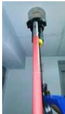
FL 16 หน้าลิฟท์พนักงาน TEST SMOKE DETECTOR 1 SET..NORMAL
