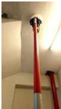
FL 21 หน้าลิฟท์พนักงาน TEST SMOKE DETECTOR 1 SET..NORMAL
