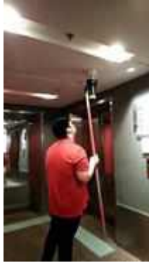
FL 26 หน้าลิฟต์ถูกค้ำ TEST SMOKE DETECTOR 1 SET..NORMAL
