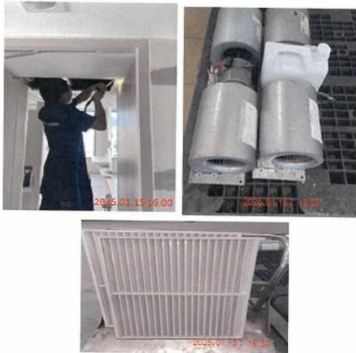
ภาพประกอบที่ 3 การทำความสะอาดเครื่องปรับอากาศ
