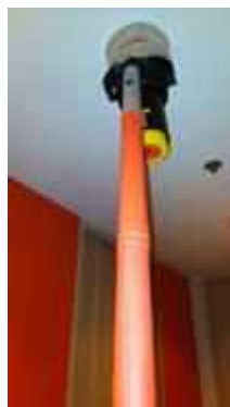
FL 18 ทางเดิน TEST SMOKE DETECTOR 5 SET..NORMAL
