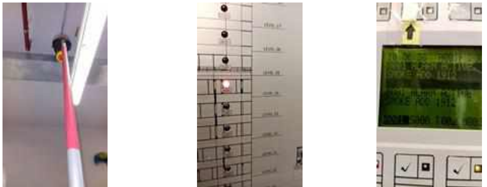
FL 24 หน้า PANTY ROOM TEST SMOKE DETECTOR 1 SET..NORMAL
