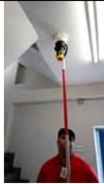
FL 29 บันไดหนีไฟ TEST SMOKE DETECTOR 1 SET..NORMAL
