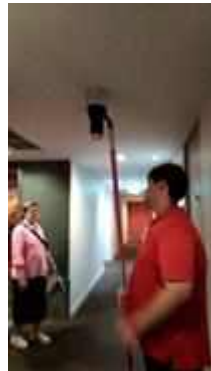
FL 28 หน้าลิฟท์ลูกค้ำ TEST SMOKE DETECTOR 1 SET..NORMAL
