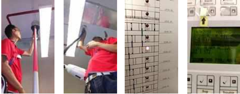
FL 22 หน้า PANTY ROOM TEST SMOKE DETECTOR 1 SET..NORMAL
