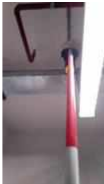
FL 21 หน้า PANTY ROOM TEST SMOKE DETECTOR 1 SET..NORMAL
