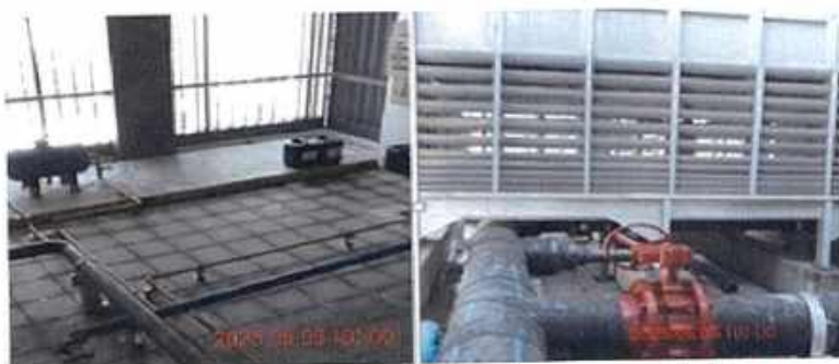
ภาพประกอบที่ 31 อุปกรณ์ระบบบำบัดและเติมสารเคมีของระบบหอฝิ่นเป็น
