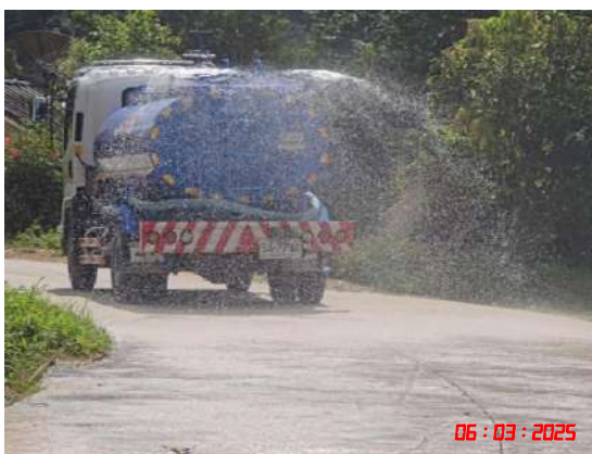
รูปที่ 7 การฉีดพรมน้ำเพื่อลดการฟุ้งกระจายของฝุ่นละออง
