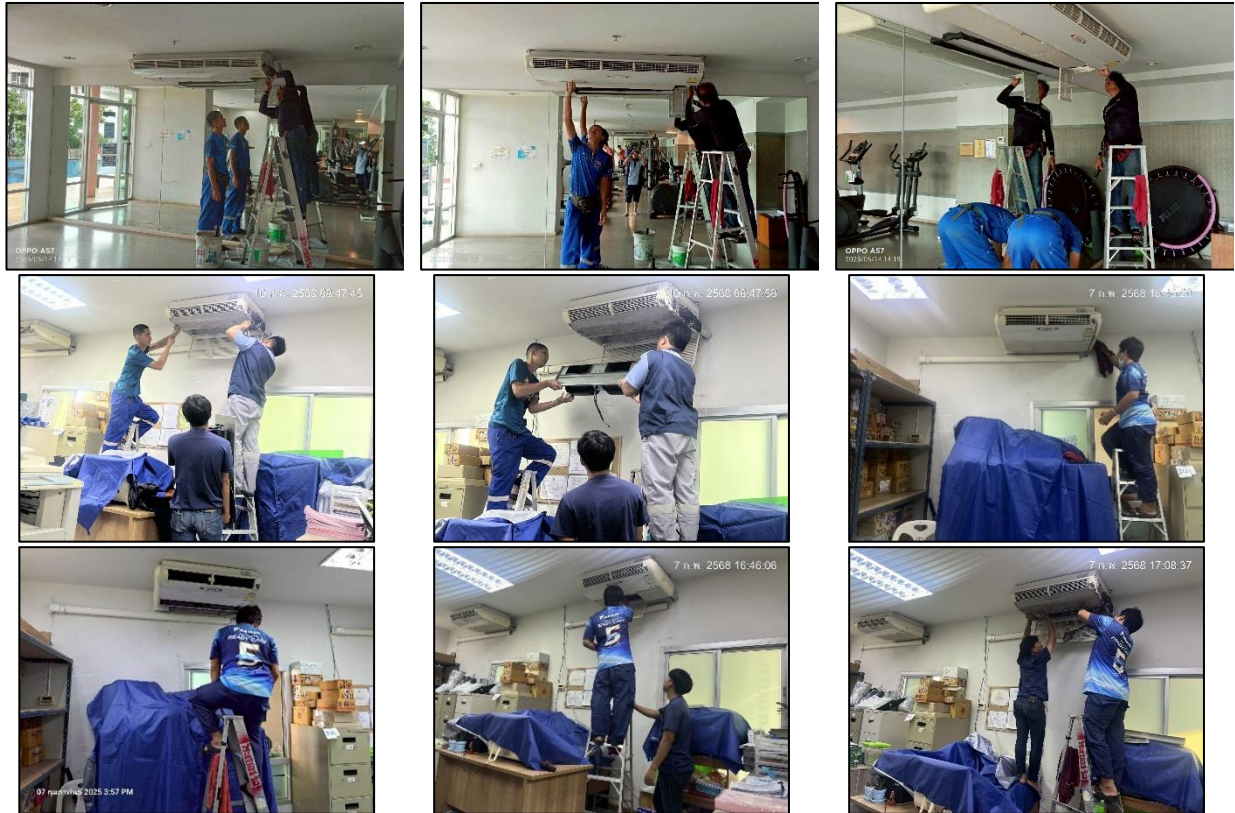
ภาพที่ 2.2-34 ล้างทำความสะอาดเครื่องปรับอากาศในพื้นที่ส่วนกลาง
