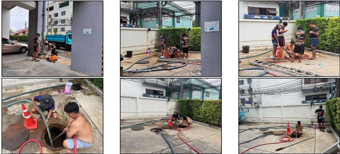
ภาพที่ 2.2-12 เจ้าหน้าที่ทำการสูบล้างของระบบบำบัดน้ำเสีย (ต่อ)
