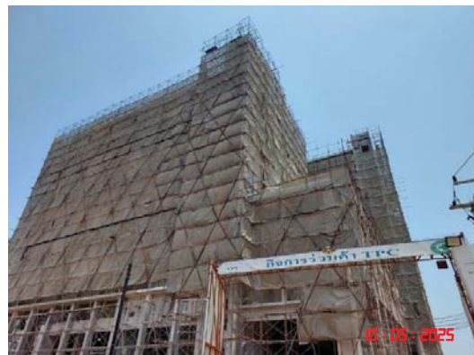
รูปที่ 4 การติดตั้ง Mesh Sheet รอบตัวอาคาร
