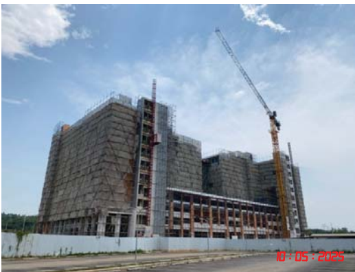
รูปที่ 4 การติดตั้ง Mesh Sheet รอบตัวอาคาร
