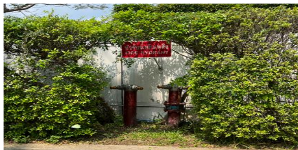
ภาพ 2-27 หัวรับน้ำดับเพลิงภายนอกอาคารติดตั้งบริเวณทิศตะวันออกใกล้กับทางเข้า-ออกโครงการ
