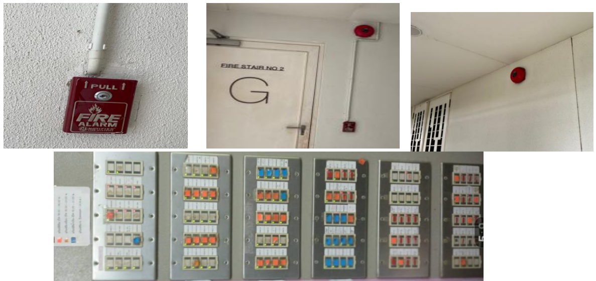
ภาพ 2-31 Fire Alarm และ กริ่งสัญญาณเตือนภัย (Alarm Bell)
