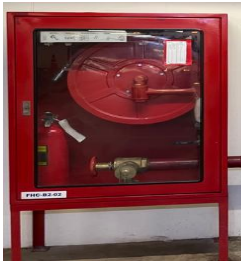
ภาพ 2-26 ตู้เก็บสายฉีดน้ำดับเพลิงพร้อมอุปกรณ์ (FHC) ติดตั้งถึงเคมีภายในตู้ และมีข้อความ / รูปภาพการใช้อุปกรณ์ดับเพลิง สะดวกในการใช้กรณีฉุกเฉิน
