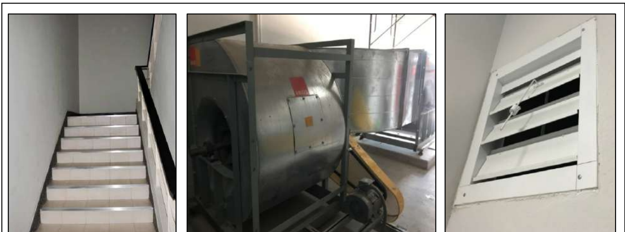
ภาพที่ 1-18 บันไดหนีไฟและพัดลมอัดอากาศ
