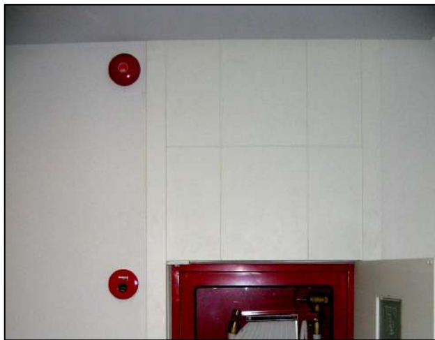
ภาพที่ 1-12 อุปกรณ์ส่งสัญญาณเตือนเหตุเพลิงไหม้ และอุปกรณ์แจ้งเหตุ
