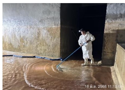
ภาพที่ 2.2-43 การทำความสะอาดล้างแทงค์เก็บน้ำประจำปี
