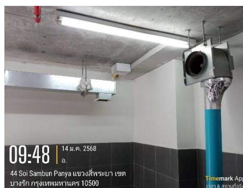
ภาพที่ 2.2-9 พัดลมดูดอากาศภายใน ห้องพักขยะเปียก
