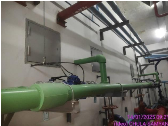
ระบบท่อน้ำปะปาก่อนเข้างัดเก็บน้ำ
