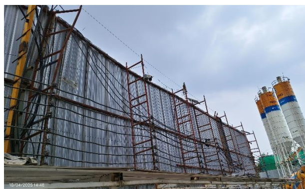
รูปที่ ก-3 รั้ว Metal Sheet สูง 6 เมตร โคยรอบบริเวณพื้นที่ก่อสร้าง
