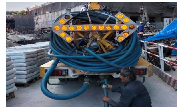
รูปที่ ก-25 มีการสูบน้ำตะกอนส่วนเกิน จากระบบบำบัดน้ำเสียไปกำจัด
