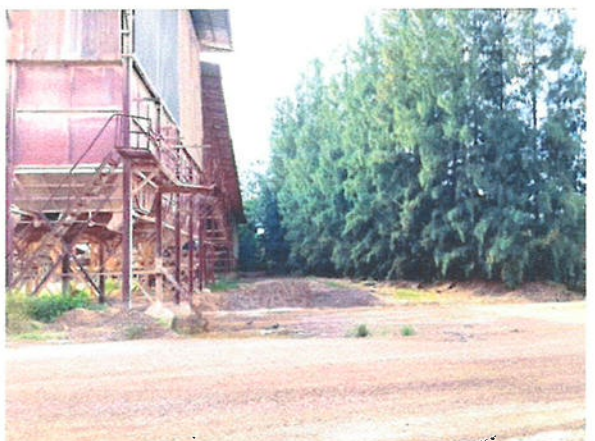
รูปที่ 12 แนวต้นไม้ภายในโรงโม่หิน ช่วยลดฝุ่นละอองขณะขนส่ง
