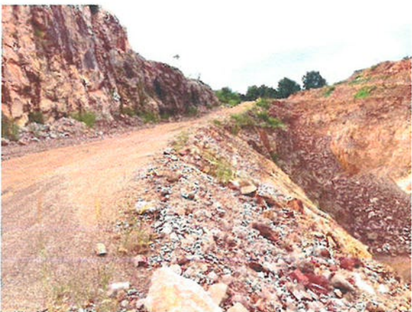
รูปที่ 3 เส้นทางสายหลักถึงหน้างานระเบิดเพื่อขนส่ง ลำเลียงหินจากหน้าเหมืองเข้าสู่โรงโม่หิน
