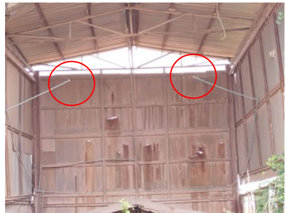
รูปที่ 10 ระบบสเปรย์น้ำ
