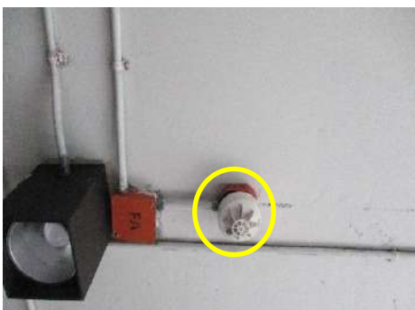
รูปที่ 2-29 เครื่องตรวจจับความร้อน (Heat Detector)
