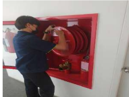
รูปที่ 2-31 ตู้เก็บสายฉีดน้ำดับเพลิง (Fire Hose Cabinet : FHC)
