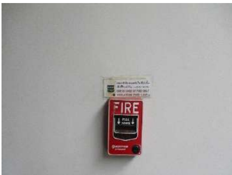
รูปที่ 2-27 สัญญาณแจ้งเหตุเพลิงไหม้ (Manual Station)
