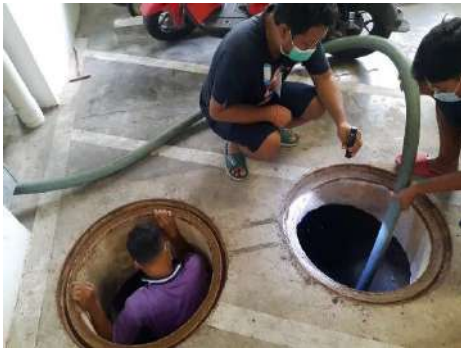
รูปที่ 2-13 การสูบน้ำออกบ่อเกรอะ
