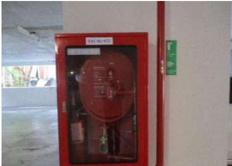
รูปที่ 2-31 ตู้เก็บสายฉีดน้ำดับเพลิง (Fire Hose Cabinet : FHC)
