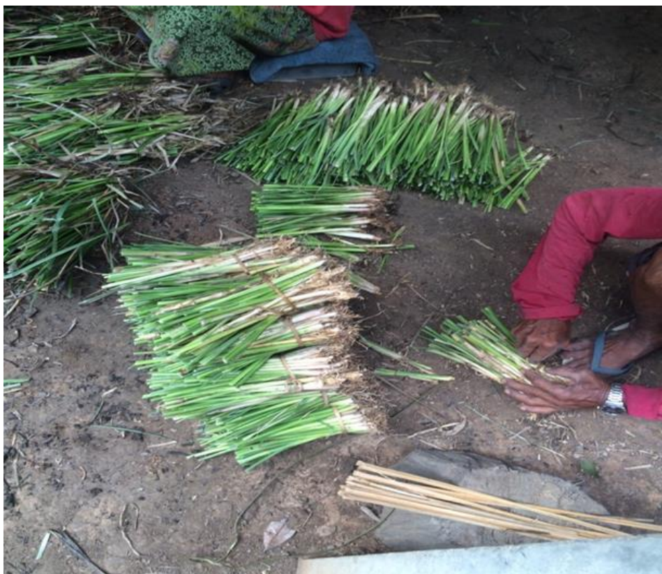
ภาพที่ แสดงการเตรียมพันธุ์ไม้หญ้าแฝก เพื่อปลูกแนวกันดินป้องกันดินสไลด์
