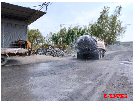
การฉีดพรมน้ำของโรงโม่หินอารีย์สันติก่อสร้าง
