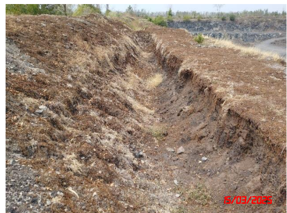
รูปที่ 12 คูระบายน้ำโดยรอบพื้นที่โครงการ
