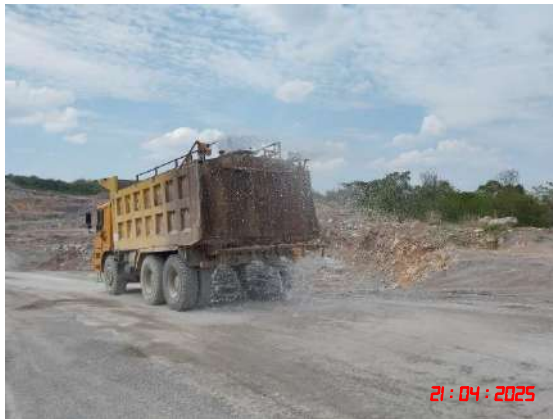
รูปที่ 9 การฉีดพรมน้ำเพื่อลดการฟุ้งกระจายของฝุ่นละออง
