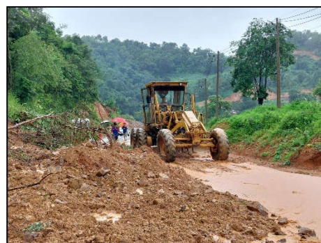
ภาพที่ 5.2.2-1 บริเวณ กม.495+400 พบดินไหลลงสู่ผิวจราจร
