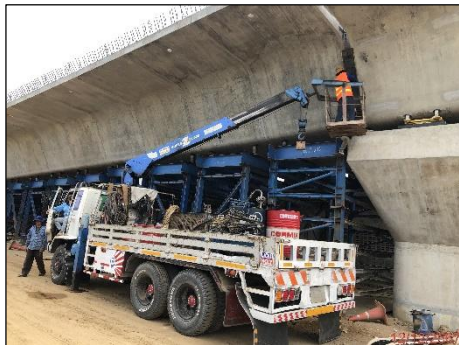
การติดตั้ง Segment Box Girder ส่วนที่อยู่บนบก กม.75+000 (ขวาทาง)
