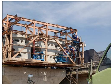
การติดตั้งอัดแรง Segment Box Girder ส่วนที่อยู่บนบก กม.75+150 (ขวาทาง)
