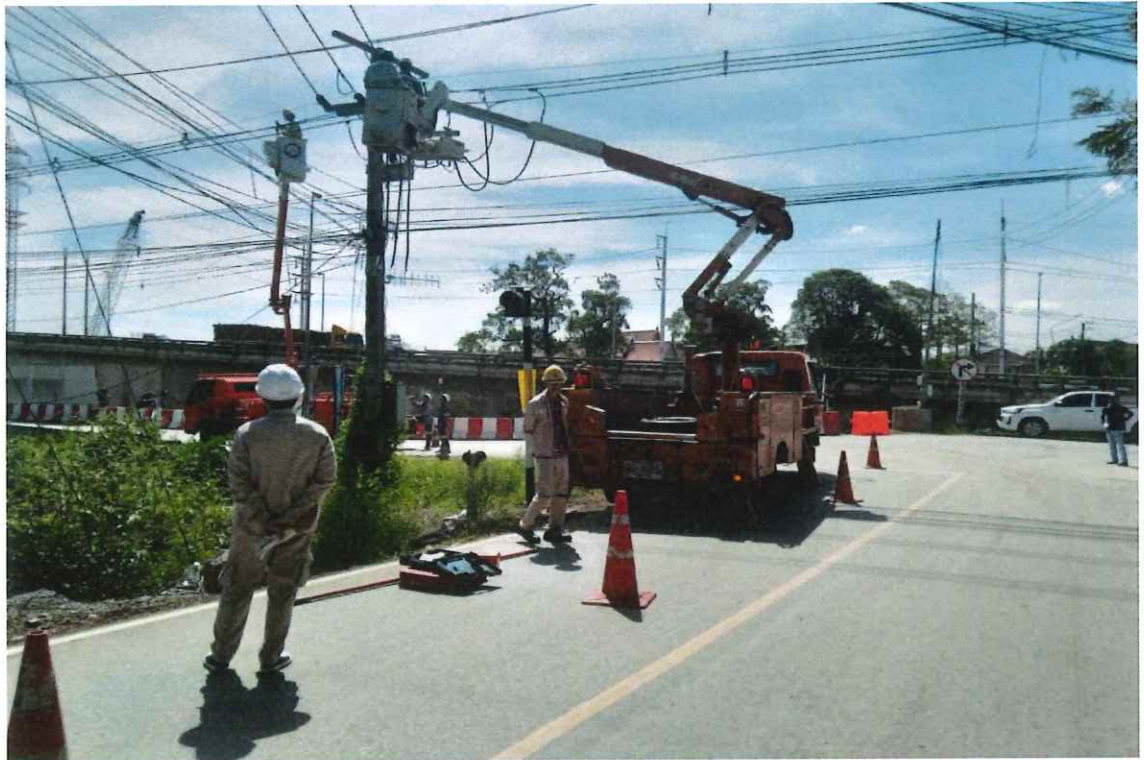
การไฟฟ้าเข้ารื้อย้ายเสาไฟฟ้า
