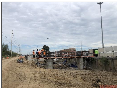
การประกอบแบบคานขวาง โครงสร้างเชิงลาดสะพาน กม.75+200 (ซ้ายทาง)
