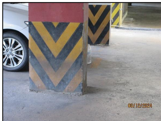
รูปที่ 12 (ต่อ) ไฟฟ้าส่องสว่าง และทาสีสะท้อนแสงในบริเวณที่สำคัญต่างๆ
