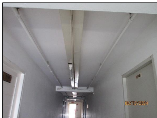
รูปที่ 14 การติดตั้งอุปกรณ์เดินสายไฟฟ้า
