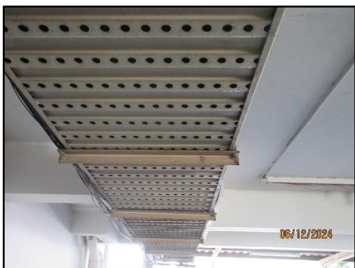
รูปที่ 14 การติดตั้งอุปกรณ์เดินสายไฟฟ้า
