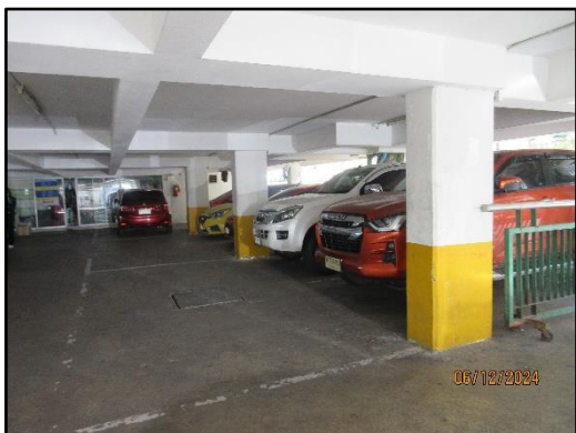
รูปที่ 12 (ต่อ) ไฟฟ้าส่องสว่าง และทาสีสะท้อนแสงในบริเวณที่สำคัญต่างๆ
