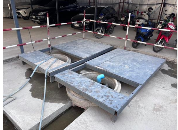
รูปที่ 60 ระบบบำบัดน้ำเสียในพื้นที่ก่อสร้าง
