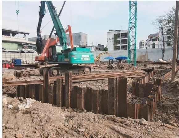
รูปที่ 63 การลง Sheet pile
