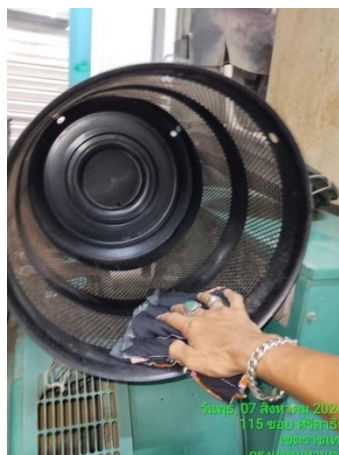
ภาพที่ 4-38 ตรวจสอบซ่อมบำรุงระบบ Generator
