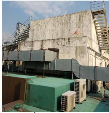
ภาพที่ 4-30 ถังสำรองน้ำาดไฟ อยู่ในสภาพดี ไม่มีรอยแตกร้าว
