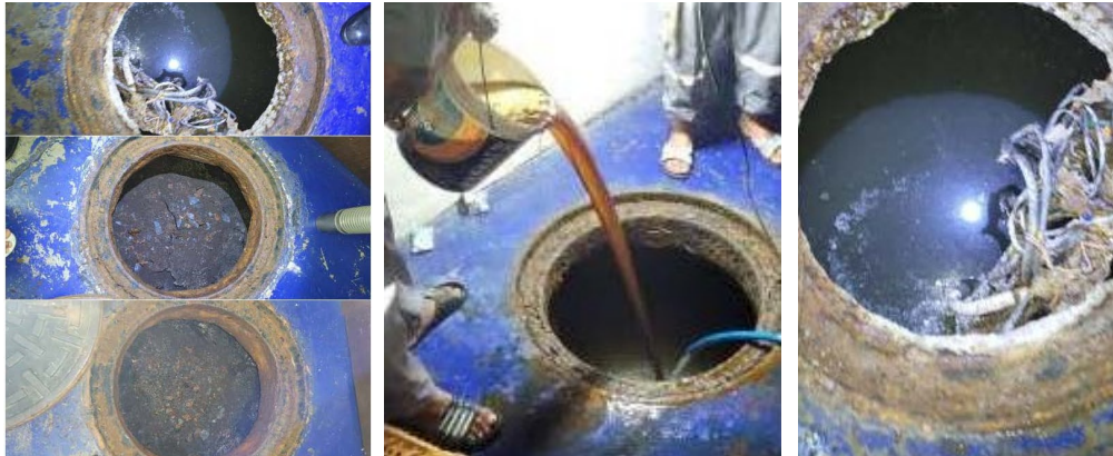
ภาพที่ 4-7 การสูบน้ำมัน และบ่อพักตะกอนออกทุก 3 เดือน
