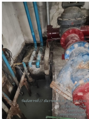
ภาพที่ 4-37 ตรวจสอบซ่อมบำรุงระบบ Fire Pump
