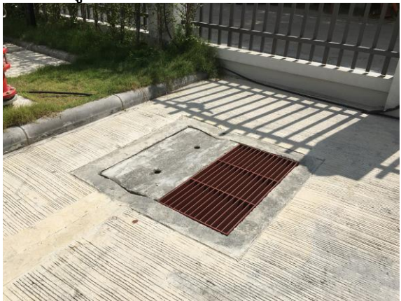
รูปที่ 3 ตะแกรงดักขยะที่บ่อพักน้ำของโครงการ
