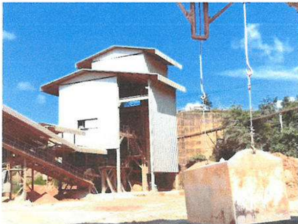
รูปที่ 14 การปิดคลุมอาคารโรงโม่หิน ชุด Hopper & Primary Crusher
