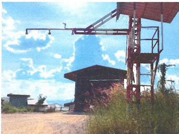
รูปที่ 20 ระบบสเปรย์น้ำบนกระเบระรถบรรทุกหิน ก่อนเทหินลงปากโม
