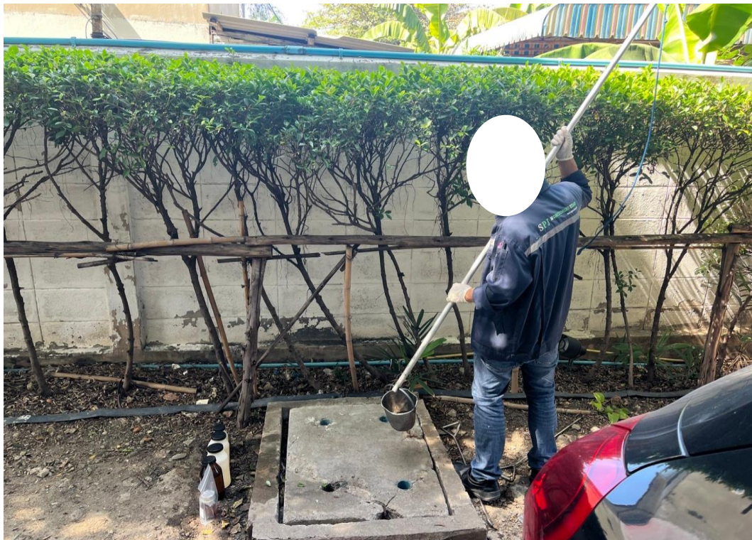
บ่อพักน้ำก่อนเข้าระบบบำบัดน้ำเสีย
