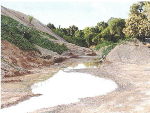
รูปที่ 20 คูระบายน้ำรอบบริเวณที่เก็บกองแร่
