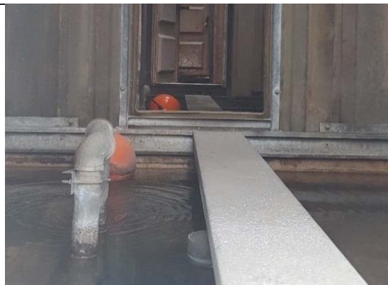
รูปที่ 2-8 ถังเก็บน้ำสำรองเพื่อการอุปโภค และน้ำสำรองดับเพลิง (ต่อ)
