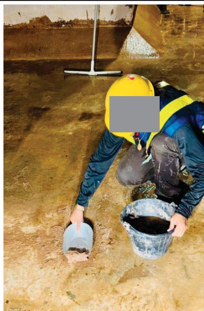
รูปที่ 2-40 การล้างบ่อพักน้ำสำรองที่อยู่ใต้ดิน (ต่อ)
