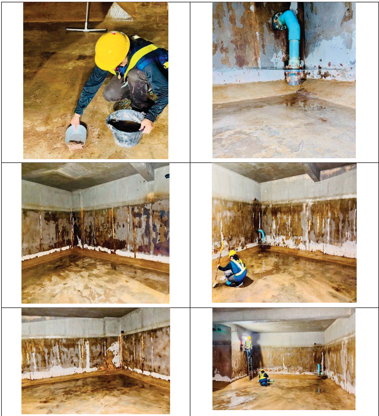
รูปที่ 3-10 การล้างทำความสะอาดถังสำรองน้ำใช้ของโครงการ
