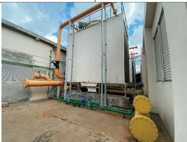
รูปที่ 2-29 หอผึ่งเย็น และการทำความสะอาดหอผึ่งเย็น
