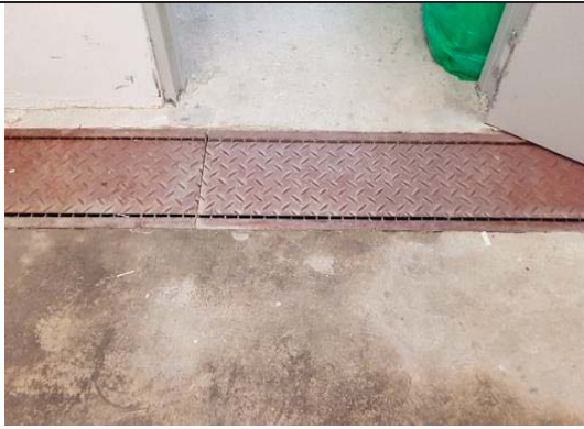
รูปที่ 2-16 รางรวบรวมน้ำเสียจากห้องพัสดุฝอยเข้าสู่ระบบบำบัดน้ำเสีย
