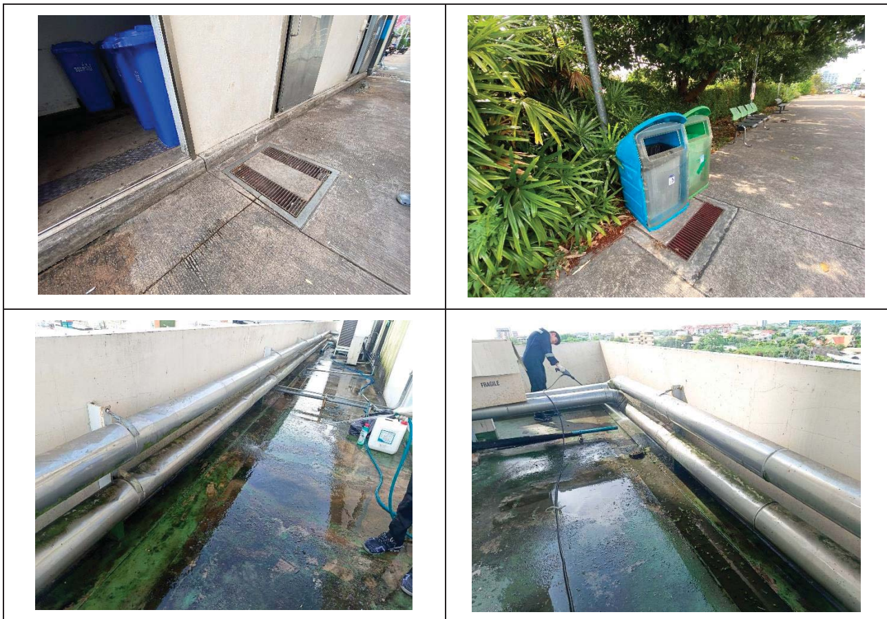
รูปที่ 3-15 การตรวจสอบและทำความสะอาดท่อระบายน้ำภายในโครงการ
