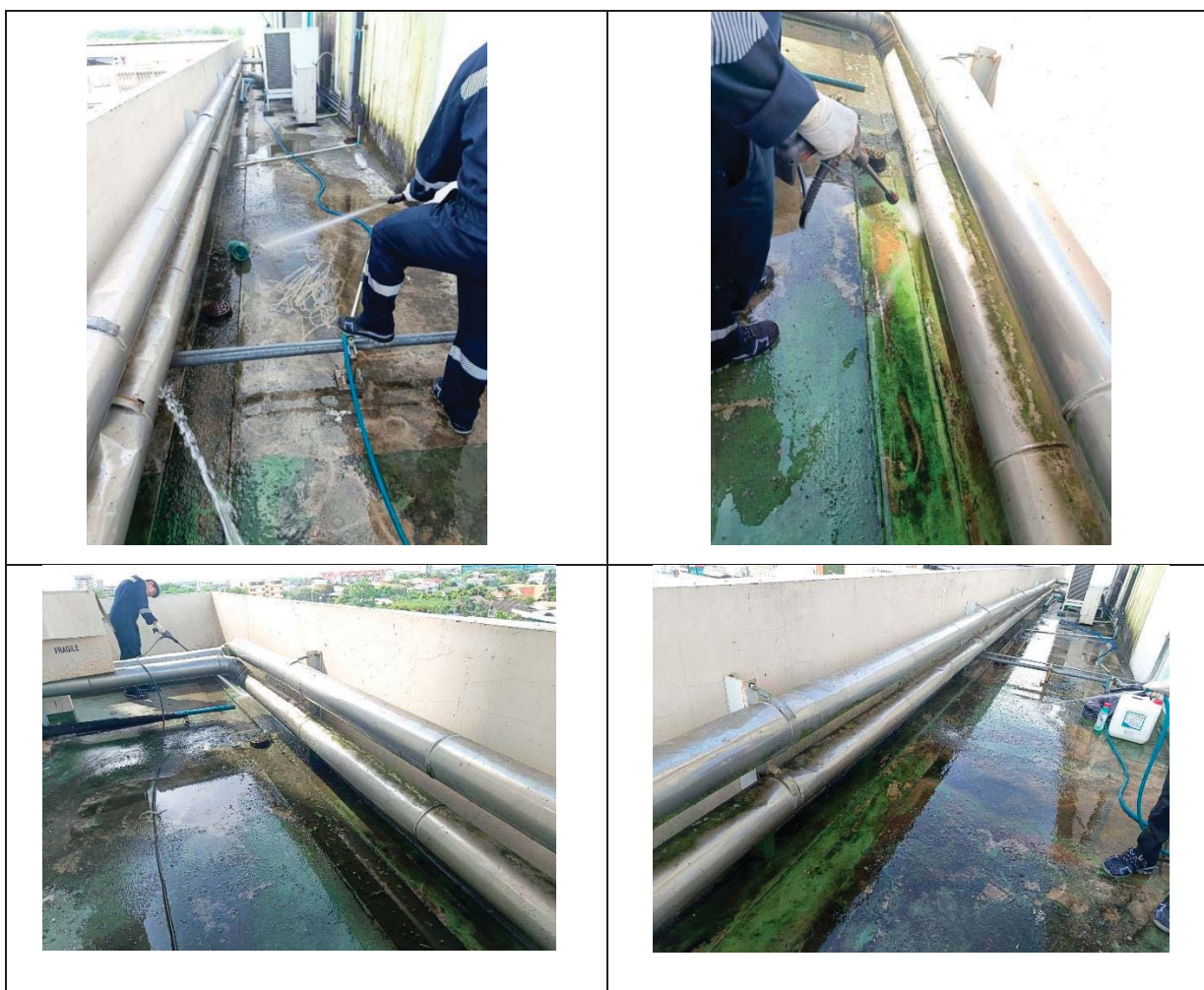
รูปที่ 2-39 การทำความสะอาด ระบบระบายน้ำบนดาดฟ้าให้ใช้งานได้อยู่เสมอ (ต่อ)
