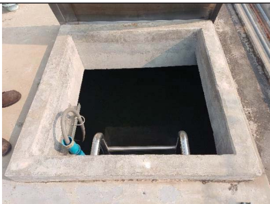
รูปที่ 2-8 ถังเก็บน้ำสำรองเพื่อการอุปโภค และน้ำสำรองดับเพลิง (ต่อ)
