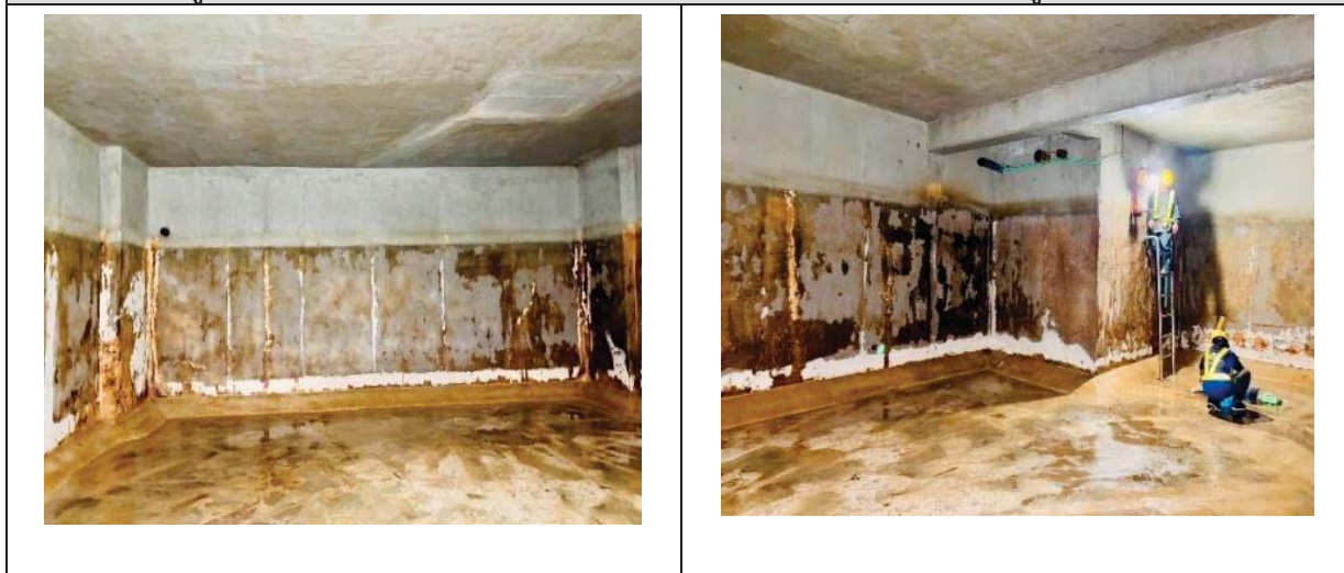
รูปที่ 2-40 การล้างบ่อพักน้ำสำรองที่อยู่ใต้ดิน
