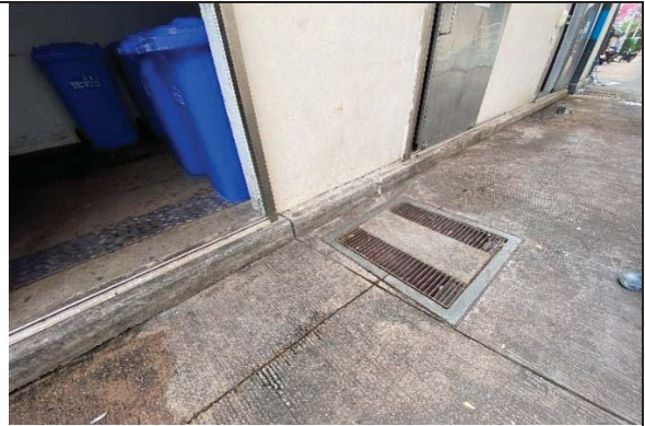
รูปที่ 2-16 รางรวบรวมน้ำเสียจากห้องพัสดุฝอยเข้าสู่ระบบบำบัดน้ำเสีย
