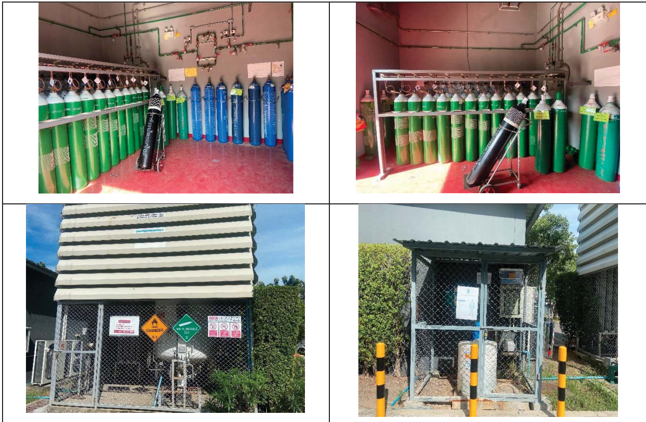
รูปที่ 2-23 ระบบก๊าซทางการแพทย์
