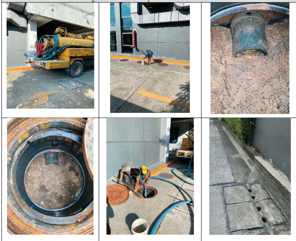
รูปที่ 2-9 การสูบน้ำจากบ่อแยกกากตะกอน และการดูแลระบบระบายน้ำให้สะอาด ไม่มีตะกอนอุดตัน
