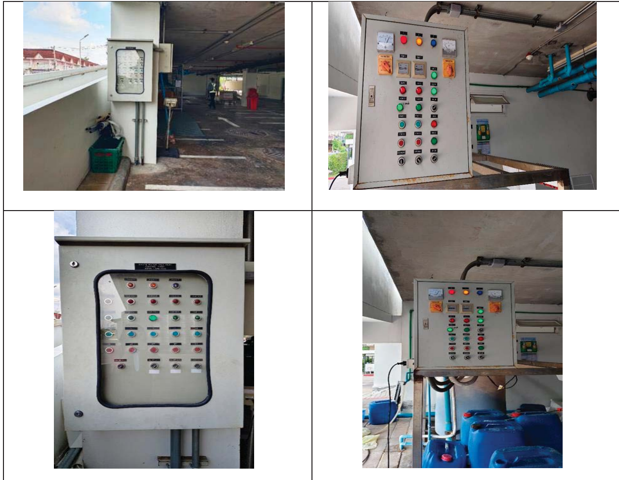
รูปที่ 2-9 การติดตั้งระบบควบคุม และมอเตอร์ไฟฟ้าสำหรับระบบบำบัดน้ำเสีย
