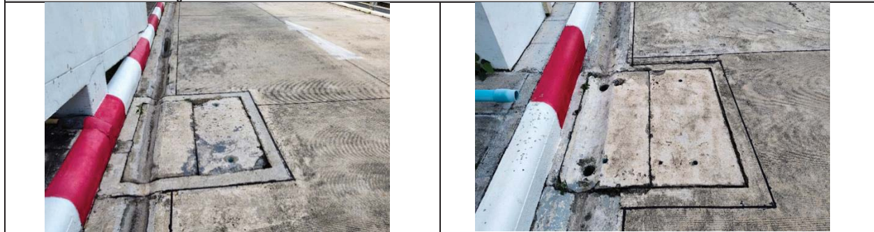
รูปที่ 2-24 รางรวบรวมน้ำเสียจากห้องพักขยะไปยังระบบบำบัดน้ำเสีย
