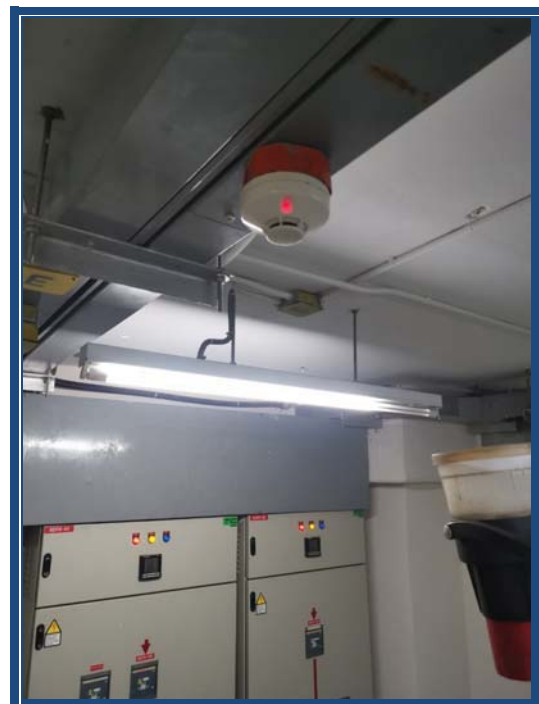
ชั้น Basement ตรวจสอบ อุปกรณ์ Smoke Detector , Manual Station , Strobe Horn
