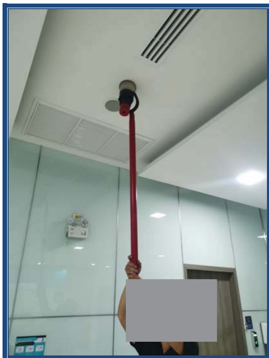
FL.2 ตรวจสอบ อุปกรณ์ Smoke Detector , Manual Station , Strobe Horn
