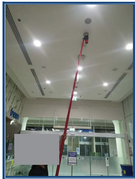
FL.1 ตรวจสอบ อุปกรณ์ Smoke Detector , Manual Station , Strobe Horn
