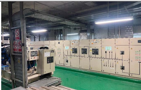
รูปที่ 2-16 ห้องเครื่องกำเนิดไฟฟ้าสำรอง
