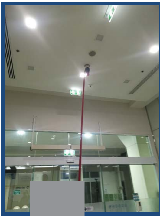
FL.1 ตรวจสอบ อุปกรณ์ Smoke Detector , Manual Station , Strobe Horn
