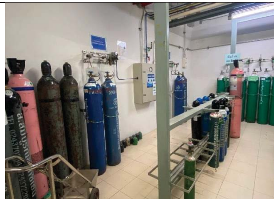
รูปที่ 2-32 การติดตั้งถัง จัดเก็บถังและท่อระบบก๊าซทางการแพทย์
