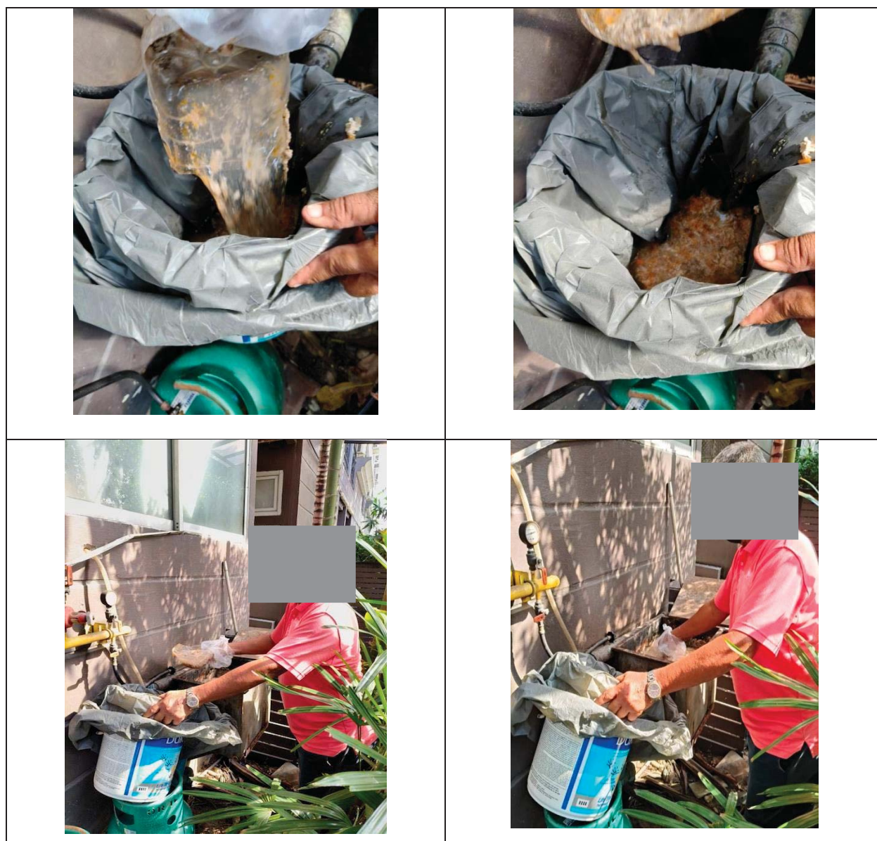
รูปที่ 2-6 การตัดไขมันจากบ่อดักไขมันเพื่อนำไปกำจัด
