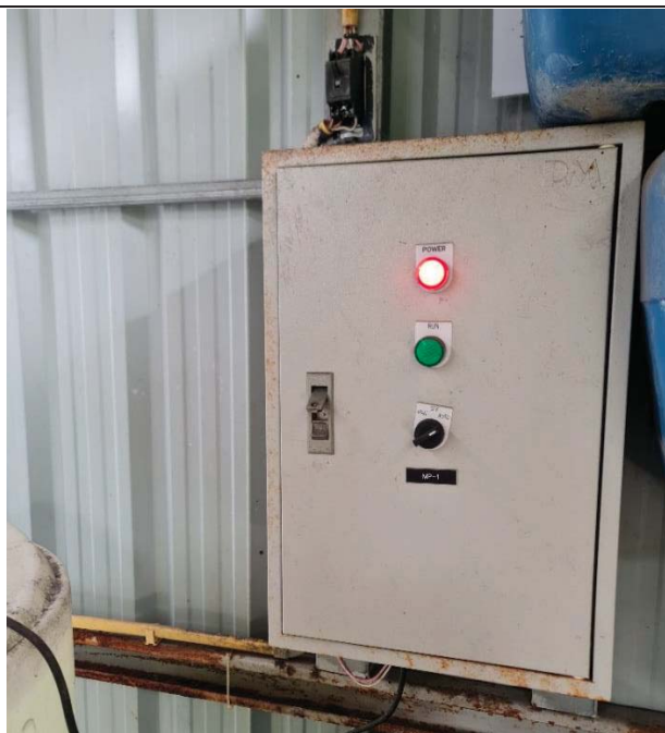
รูปที่ 2-8 การติดตั้งตู้ควบคุมไฟฟ้าระบบบำบัดน้ำเสีย
