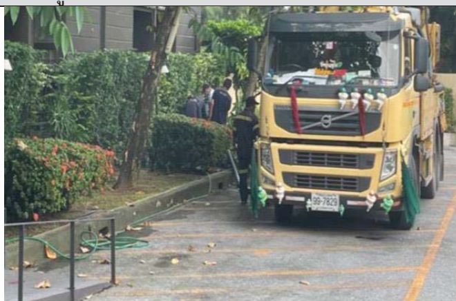
รูปที่ 2-7 การสูบลากตะกอนจากถังกรองของระบบบำบัดน้ำเสีย
