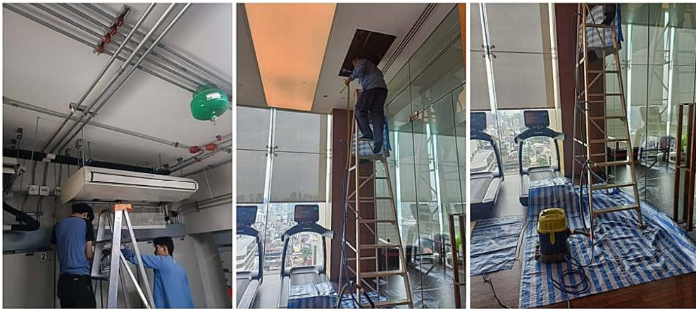
ภาพที่ 4-38 ทำความสะอาดระบบปรับอากาศภายในอาคาร
