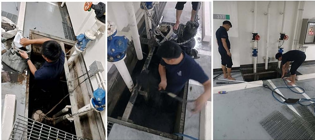
ภาพที่ 4-26 แนวท่อระบายน้ำ และรางระบายน้ำ ทำความสะอาดบ่อพักน้ำและรางระบายน้ำ
