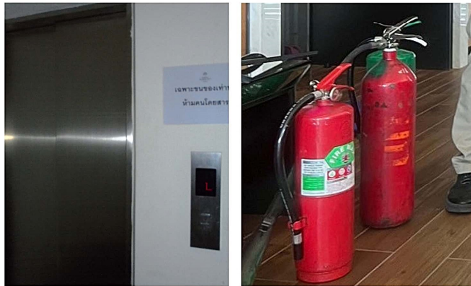
ภาพที่ 4-18 ลิฟต์ดับเพลิง และถังเคมีดับเพลิง
