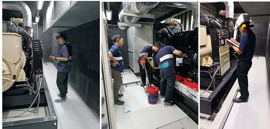
ภาพที่ 4-41 ตรวจสอบดูแลรักษาระบบเครื่องสร้างไฟฟ้าฉุกเฉิน (Generator)
