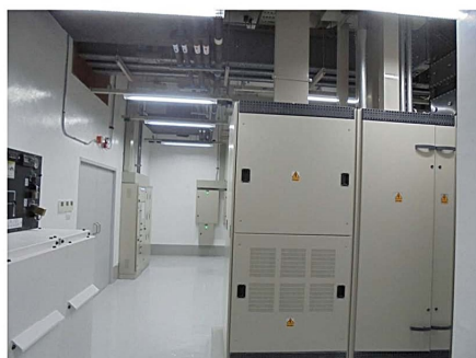
ภาพที่ 4-11 ห้องเครื่องไฟฟ้า MDB และห้องเครื่องไฟฟ้าสำรอง
