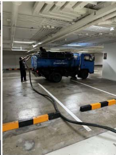
ภาพที่ 4-26 แนวท่อระบายน้ำ และรางระบายน้ำ ทำความสะอาดปอพักน้ำและรางระบายน้ำ
