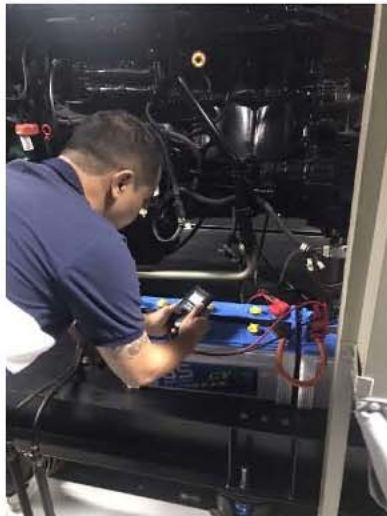
ภาพที่ 4-41 ตรวจสอบดูแลรักษาระบบเครื่องสำรองไฟฟ้าฉุกเฉิน (Generator)
