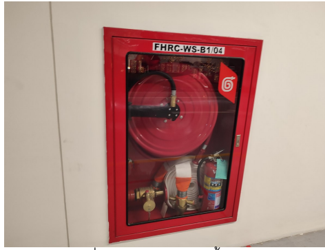
ภาพที่ 4-17 ตู้เก็บสายฉีดน้ำดับเพลิง
