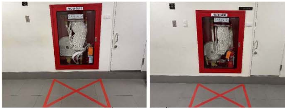
ภาพที่ 4-17 ตู้เก็บสายฉีดน้ำดับเพลิง
