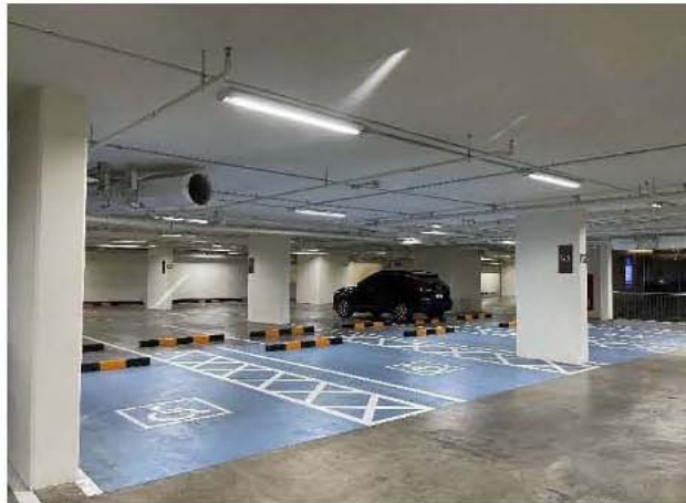
ภาพที่ 4-6 พัดลมระบายอากาศ และช่องระบายอากาศภายในชั้นจอดรถ
