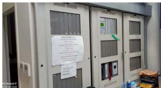
ภาพที่ 4-19 แผงควบคุมการรับสัญญาณแจ้งเหตุเตือนอัคคีภัย
