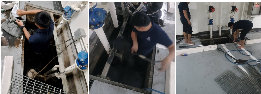
ภาพที่ 4-26 แนวท่อระบายน้ำ และรางระบายน้ำ ทำความสะอาดบ่อบักน้ำและรางระบายน้ำ
