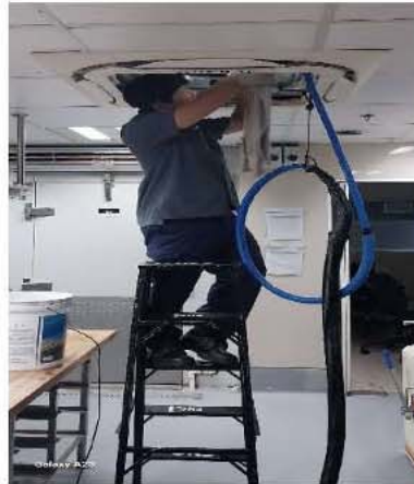
ภาพที่ 4-38 ทำความสะอาดระบบปรับอากาศภายในอาคาร
