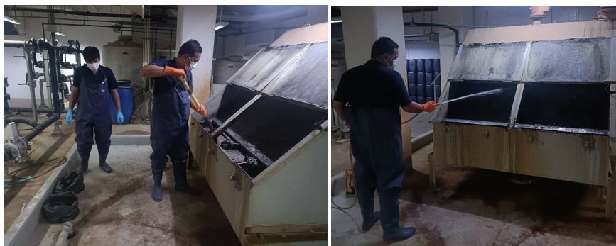
ภาพที่ 4-39 ดูดตะกอนจากบ่อพักตะกอนของอาคาร
