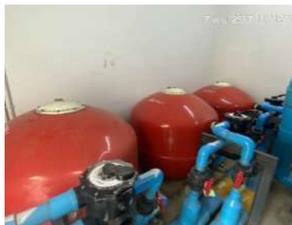
ระบบกรองสระว่ายน้ำ ภาพที่ 2-8 (ต่อ) สระว่ายน้ำของโครงการ
