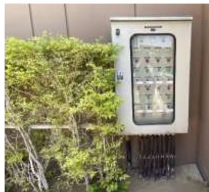
ตู้ควบคุมระบบบำบัดน้ำเสีย
