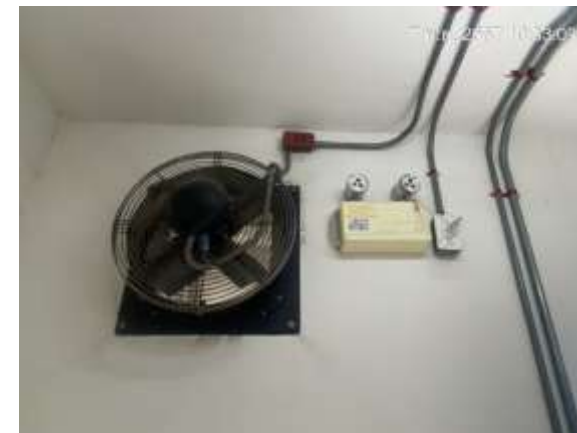
พัดลมระบายอากาศในห้อง MDB
