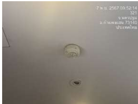
เครื่องตรวจจับควัน ภาพที่ 2-3 (ต่อ) ระบบอัคคีภัย
