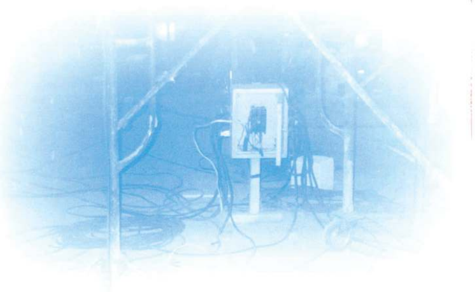
การรั่วไหลของกระแสไฟฟ้าจากตู้ไฟฟ้าชั่วคราว
