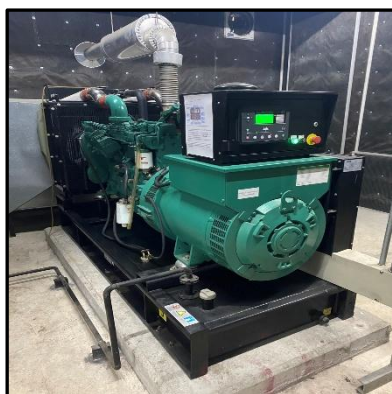
ภาพที่ 6 ระบบจ่ายไฟฟ้าหลัก และไฟฟ้าสำรอง
