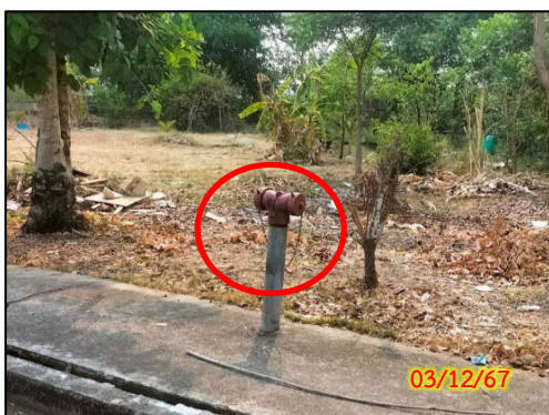
รูปที่ 2.2-11 หัวรับน้ำดับเพลิงภายในโครงการ
