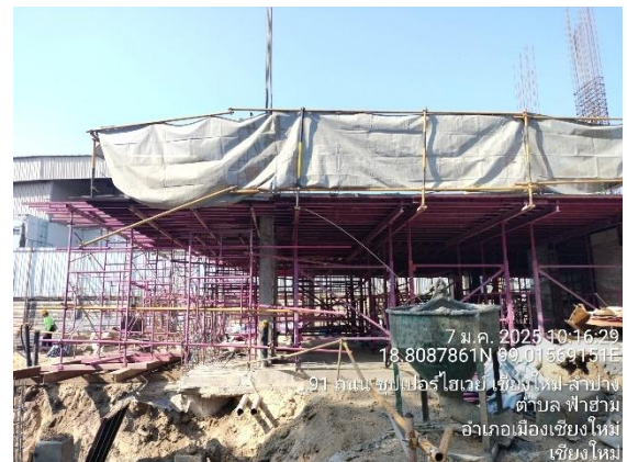
รูปที่ 2-23 การปิดคลุมอาคารด้วยผ้าใบกันฝุ่น
