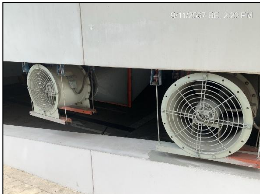
ภาพที่ 7 ระบบระบายอากาศชั้นใต้ดินของอาคาร
