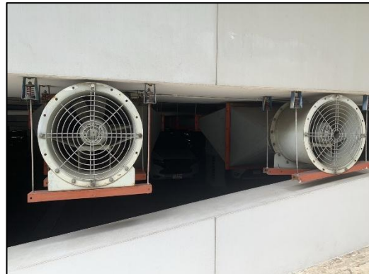
ภาพที่ 7 ระบบระบายอากาศชั้นใต้ดินของอาคาร
