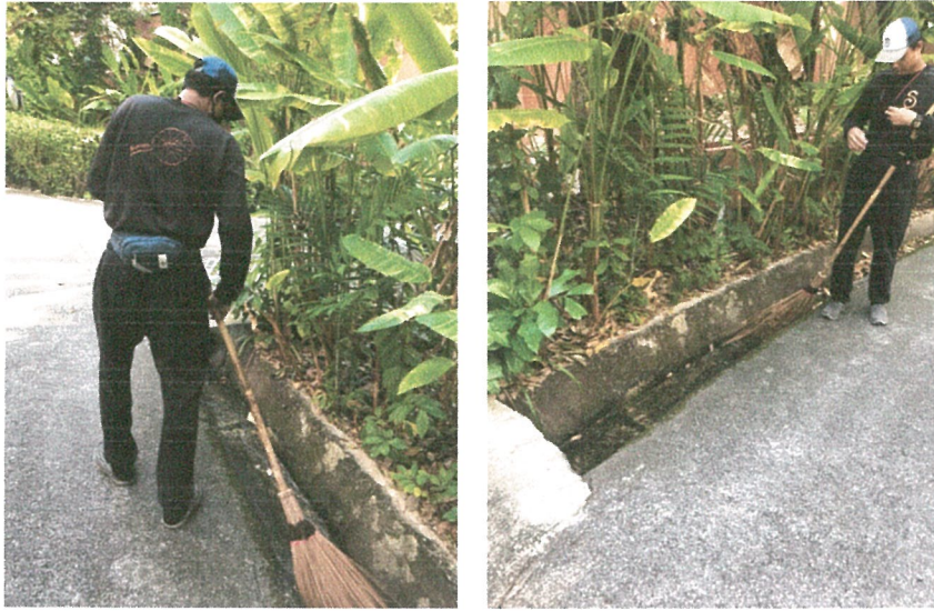
รูปภาพที่ 2.5 การทำความสะอาดรางระบายน้ำ/ท่อระบายน้ำ
