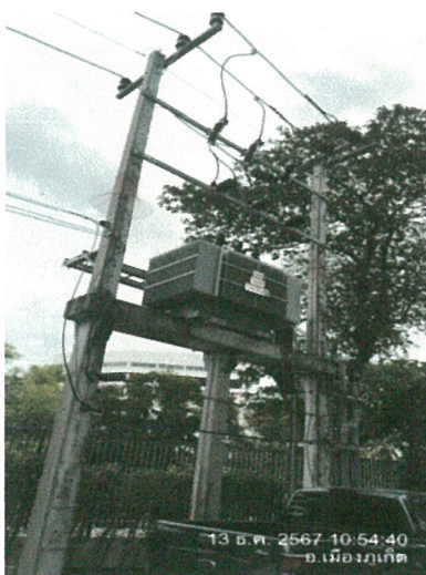
รูปภาพที่ 2.24 หม้อแปลงไฟฟ้า/สัญลักษณ์อันตรายจากไฟฟ้าแรงสูง
