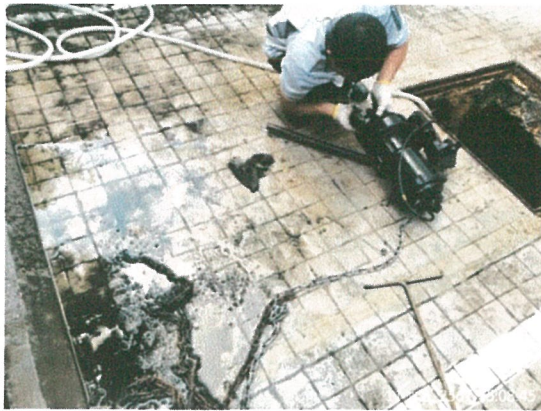
รูปภาพที่ 2.3 การตรวจเช็คระบบบำบัดน้ำเสีย
