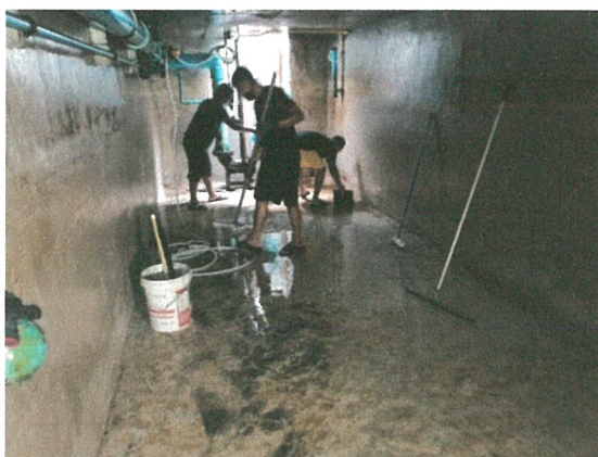
รูปภาพที่ 2.43 การล้างถังเก็บน้ำสำรอง
