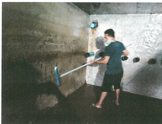
รูปภาพที่ 2.43 การล้างถังเก็บน้ำสำรอง
