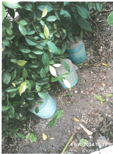
รูปภาพที่ 2.4 ท่อสำหรับระบายก๊าซมีเทน
