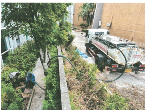
รูปภาพที่ 2.44 การสูบน้ำตะกอน
