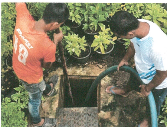
รูปภาพที่ 2.44 การสูบน้ำตะกอน
