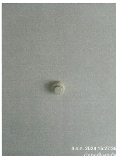
รูปภาพที่ 2.33 เครื่องตรวจจับควัน
